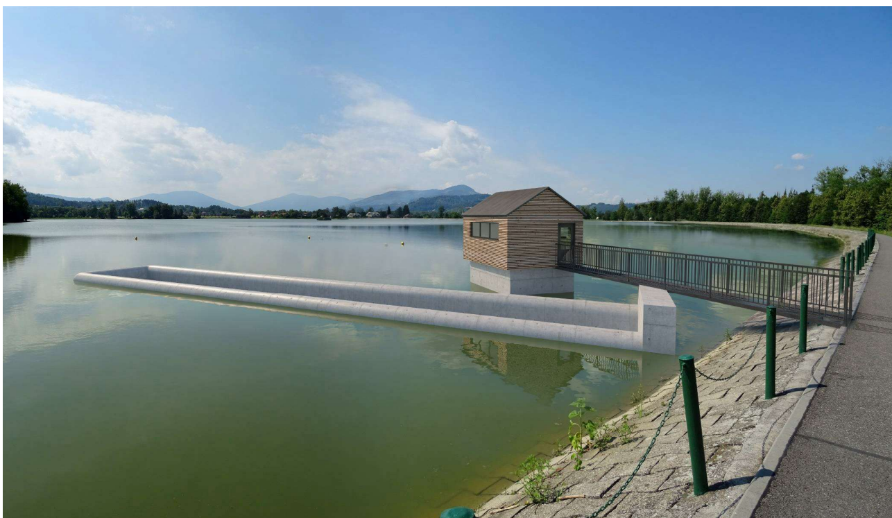
Obr. 6 Pohled na přeliv a strojovnu spodní výpusti z koruny hráze - návrh.
