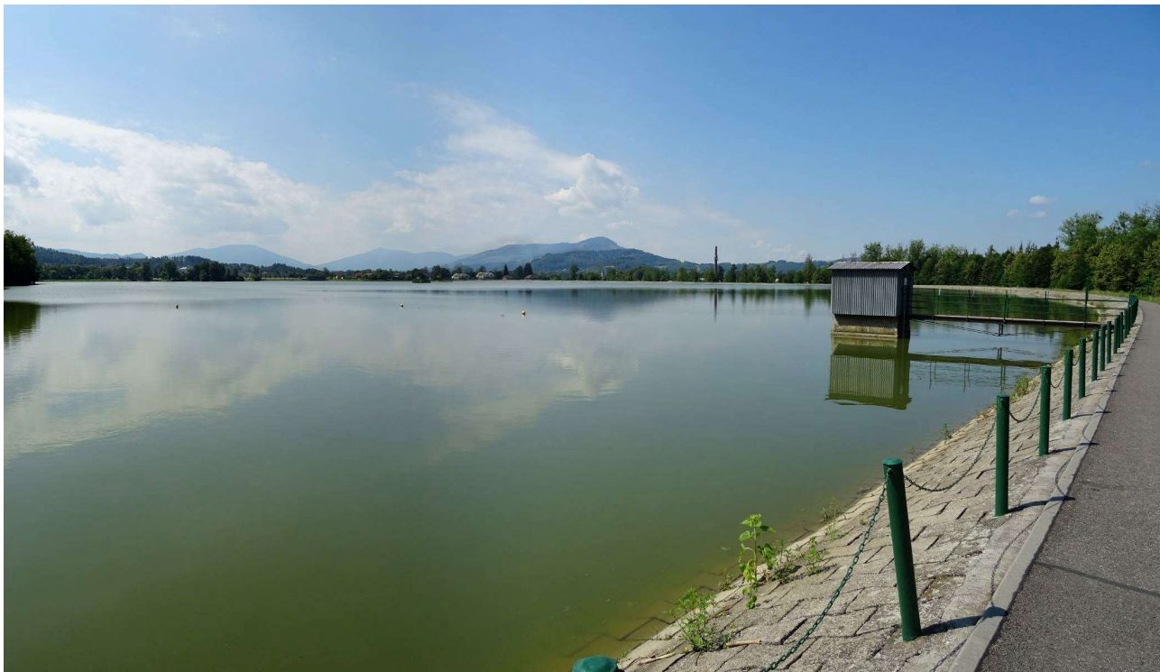
Obr. 5 Pohled na přeliv a strojovnu spodní výpusti z koruny hráze - současný stav.
