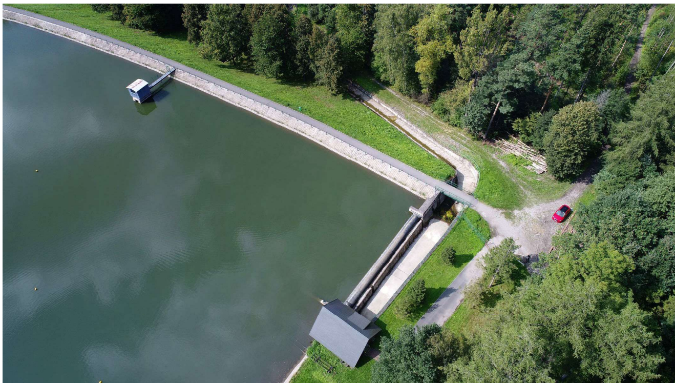
Obr. 3 Letecký pohled z pravého břehu - současný stav.
